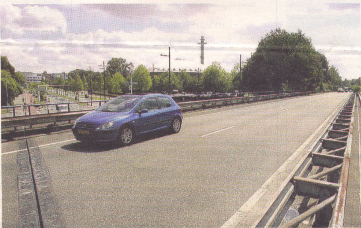
De Tilburgseweg ter hoogte van de Noord-Brabantlaan. In het najaar wordt de weg verbeterd. De gemeente hoopt daarmee de geluidhinder en de luchtverontreiniging voor omwonenden te beperken. foto Irene Wouters
